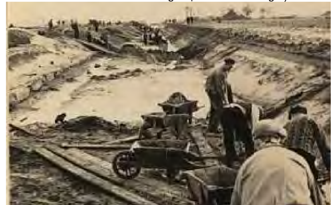
Aanleg van het Van Starckenborghkanaal, ca. 1937 (bron: Kruiwagen, kiepkar en schop | De Verhalen van Groningen)
